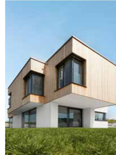
Stakleno krilo nema vidljivi plastični okvir krila s vanjske strane i **stoga izgleda kao fiksno ostakljenje** – no to je prozor koji se može otvoriti.
