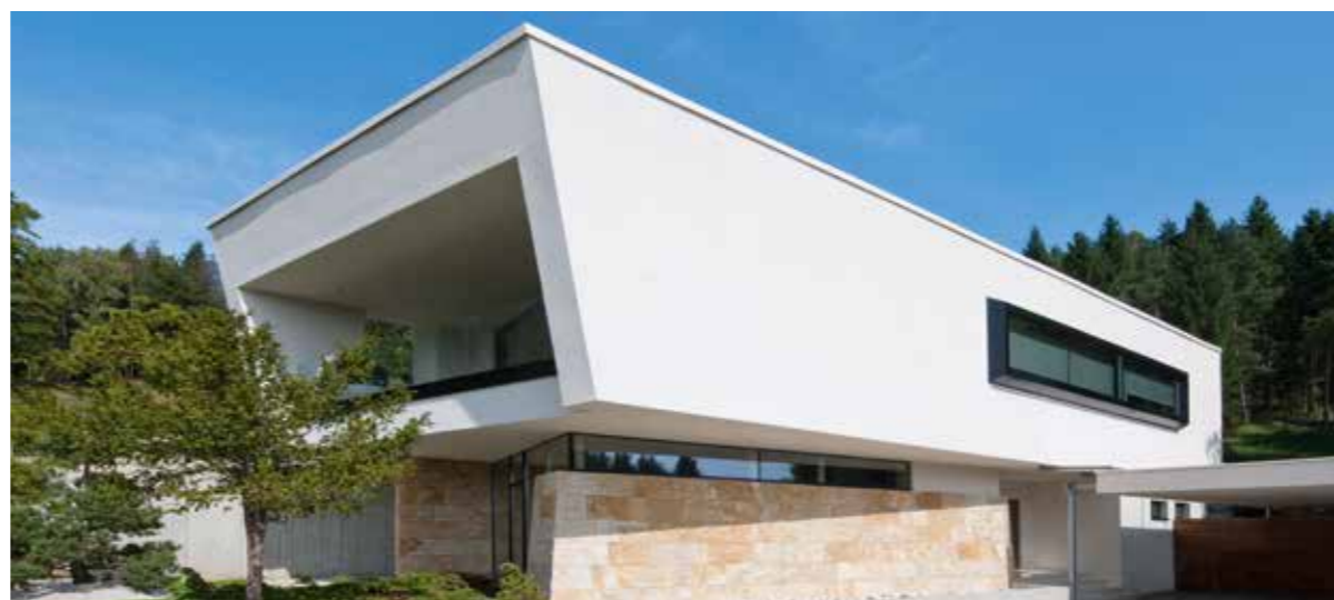
MASIVNO POMIČNO Bijela, jasno strukturirana konstrukcija izgleda kao da pluta na kamenoj bazi. Ulazna vrata od drva/aluminija naglašavaju ovo arhitektonsko rješenje. Kuća za jednu obitelj (A), vrata: HT 410, prozor HF 310
