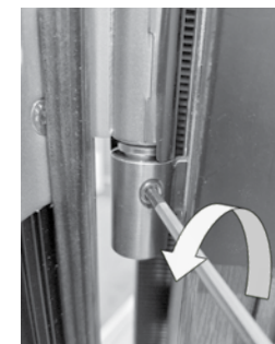
Slăbiți șurubul de fixare.
