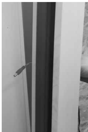
2. Scoateți conectorul prin fereastra basculată.
